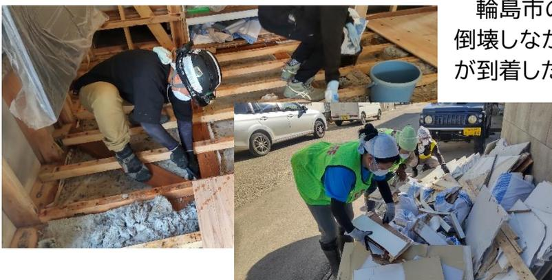
輪島市の真新しいブルーの壁のお宅は、地震では倒壊しなかったものの、豪雨で浸水しました。私たちが到着した時点で、すでに別のボランティア団体が入っていて大工さんさながらに床や壁をはがし、水でボロボロになった断熱材を土嚢袋に入れて外に出された状態でした。壁材は細かくわり土嚢袋に入れる作業、廃材、水浸しの断熱材、廃材などをトラックに積み、ごみ集積場に運びました。
